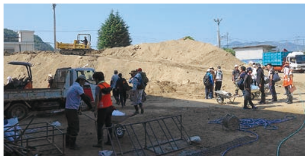
各場所で搬出された土砂は小学校の校庭に集められています。
