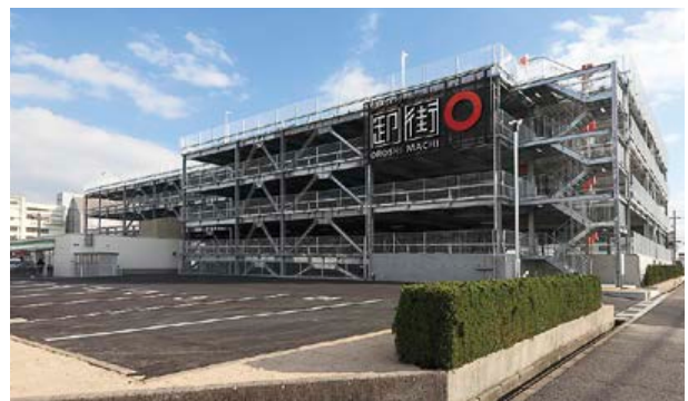
主な施設事業(共同駐車場)
