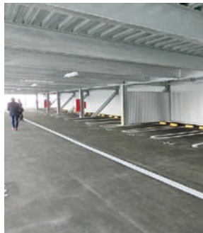
立体駐車場中の様子
