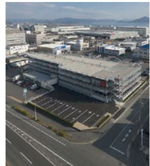
北側から空撮した立体駐車場
