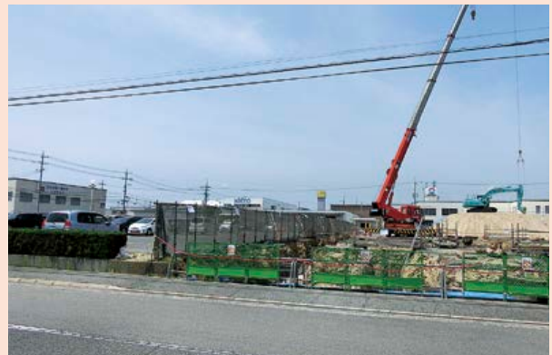
立体駐車場工事の様子
