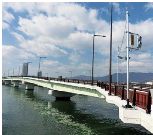
完成した新八幡川橋
