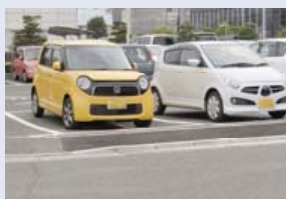
歩道切り下げ工事後
