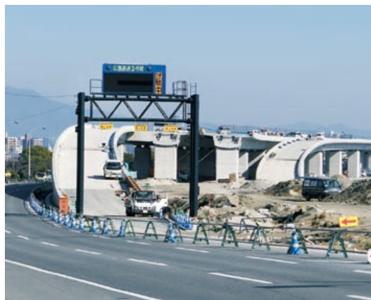
工事が進む商工センター側太田川大橋入口(1月末現在)
