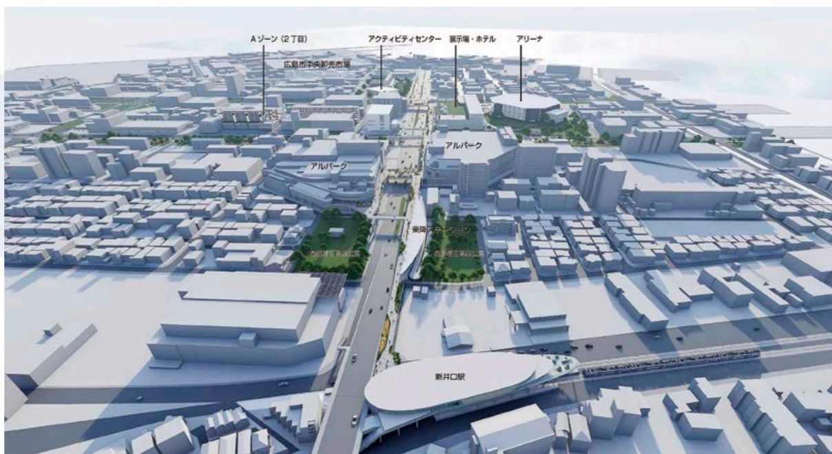
北からの全景(新井口駅から市場方向の商工センター全体)
