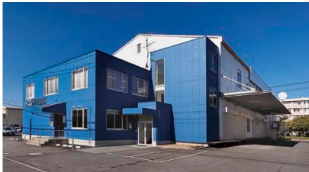
▲ 主な施設事業(共同倉庫事務所)
