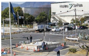
撤去中の排水用ポンプ施設
