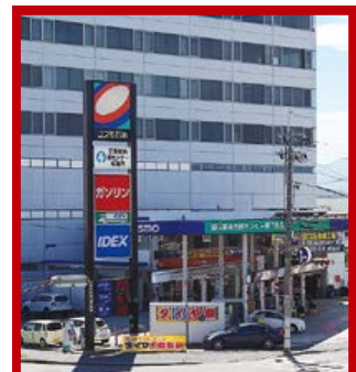
卸センター第一給油所
